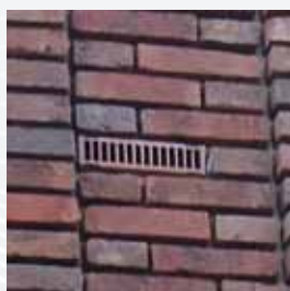
Exemple pratique de grille pour façade en briques
