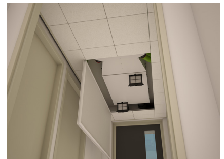
Vue de dessous - Entretien de filtres
